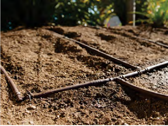
وحدة PLD مُركبة
