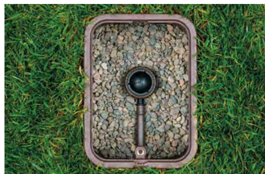
Zamontowany automatyczny zawór płuczący
