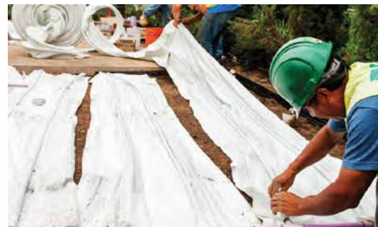
Nainštalovaná rohož Eco-Mat
