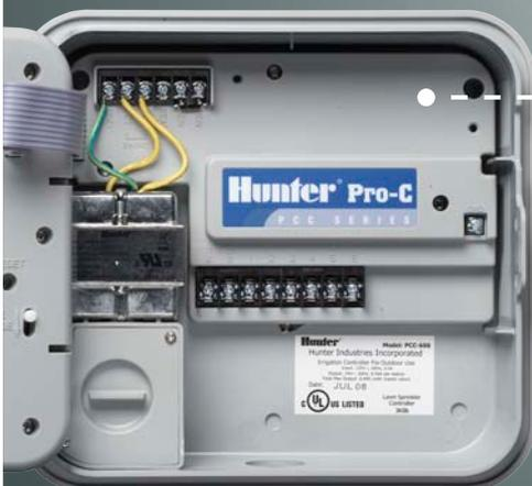
Concebido para permitir a instalação do módulo Solar Sync dentro do armário do controlador
