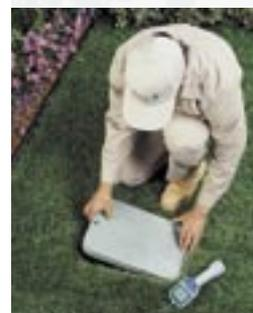
Vuelva a poner la tapa de la arqueta, y su programador totalmente impermeable estará protegido de la lluvia, de la suciedad y de otros contaminantes.
