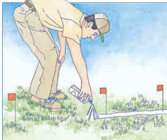
Avant de faire la tranchée, repérez le tracé de votre système d'arrosage à l'aide de petits drapeaux et à la bombe de peinture.
