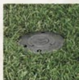
6. Choisissez et installez la buse de votre choix. Réglez votre secteur d'arrosage.
