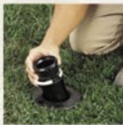
2. Insérez le tube court de l'adaptateur du nouveau système. Ajoutez le clips pour maintenir l'adaptateur.
