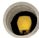
① Can Suyu Vanası
